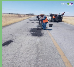
EL DEPARTAMENTO DE OBRAS PÚBLICAS LLEVA A CABO EL BACHEO EN DIVERSAS CARRETERAS DEL MUNICIPIO
